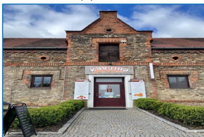
Foto 1 - celkový pohled na budovu
