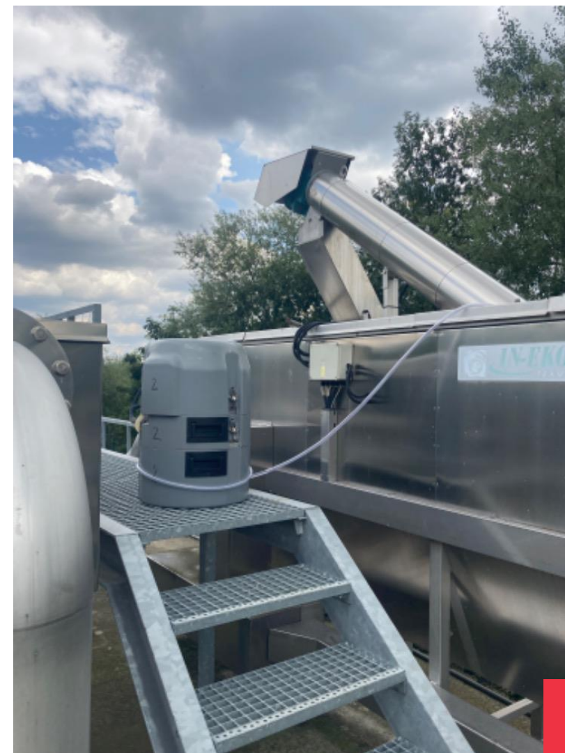
Obr. 4: Umístění automat. vzorkovače HACH na přítoku při 24hod. měření, červenec 2024
