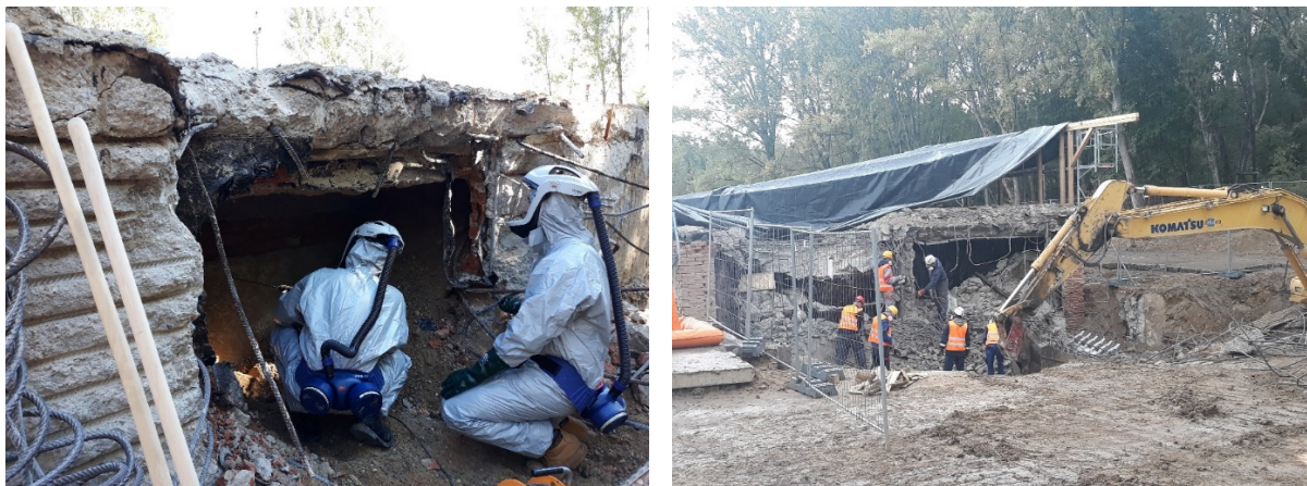
Obr. 3: Úvodní rekognoskace úložiště a demolice betonového úložiště
